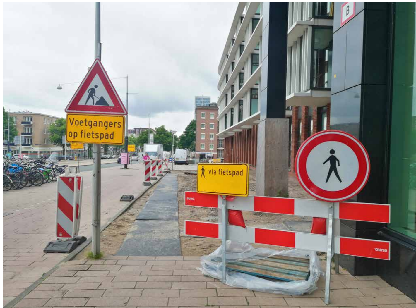
AANWIJZINGEN VOOR VOETGANGERS De vernieuwingen in de Kolenkit zorgen al jaren voor opengebroken straten. De platen in het zand worden schijnbaar vaak gezien als geïmproviseerd voetpad. Ik kwam van de andere kant, over de platen, en zag de hoeveelheid borden pas toen ik me omdraaide. Bos en Lommer, Judith Leijdekkers
