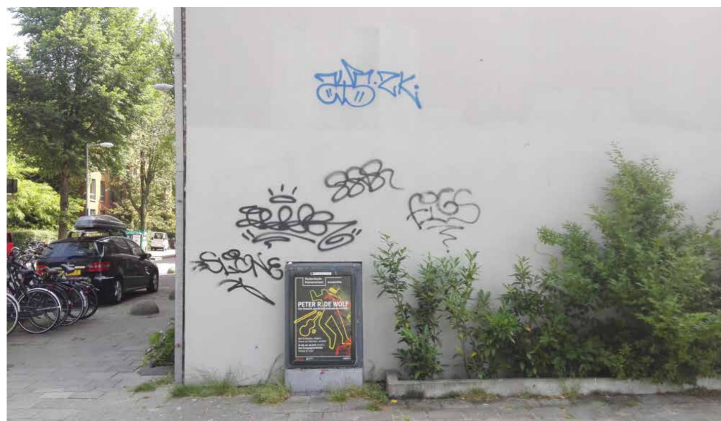
STEEDS OPNIEUW GETAGD Blinde zijmuur van een woningblok met een geveltuin ervoor om het de graffiti-puiters lastig te maken. De muur wordt steeds opnieuw gewit en steeds opnieuw getagd. Op de muur is de lijn te zien van de laatste verfbeurt of van een aangebrachte anti-graffiti coating. Waarschijnlijk met dank aan het elektriciteitskastje als opstapje, is het gelukt om de blauwe tag boven de lijn te zetten. (Hoek Van Hogendorpstraat/ Van Bossepad) Staatsliedenbuurt, Richelle Wansing
