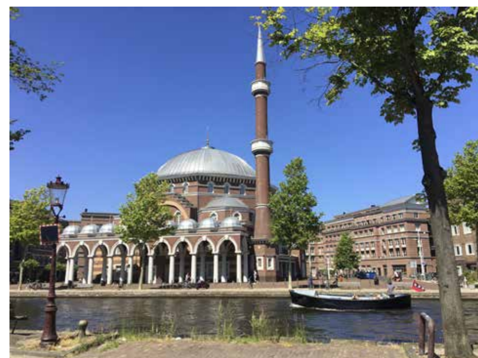
WESTERMOSKEE De Turkse Westermoskee aan de Schinkel is niet zonder slag of stoot tot stand gekomen. Kinkerbuurt, Jacintha Scheek
