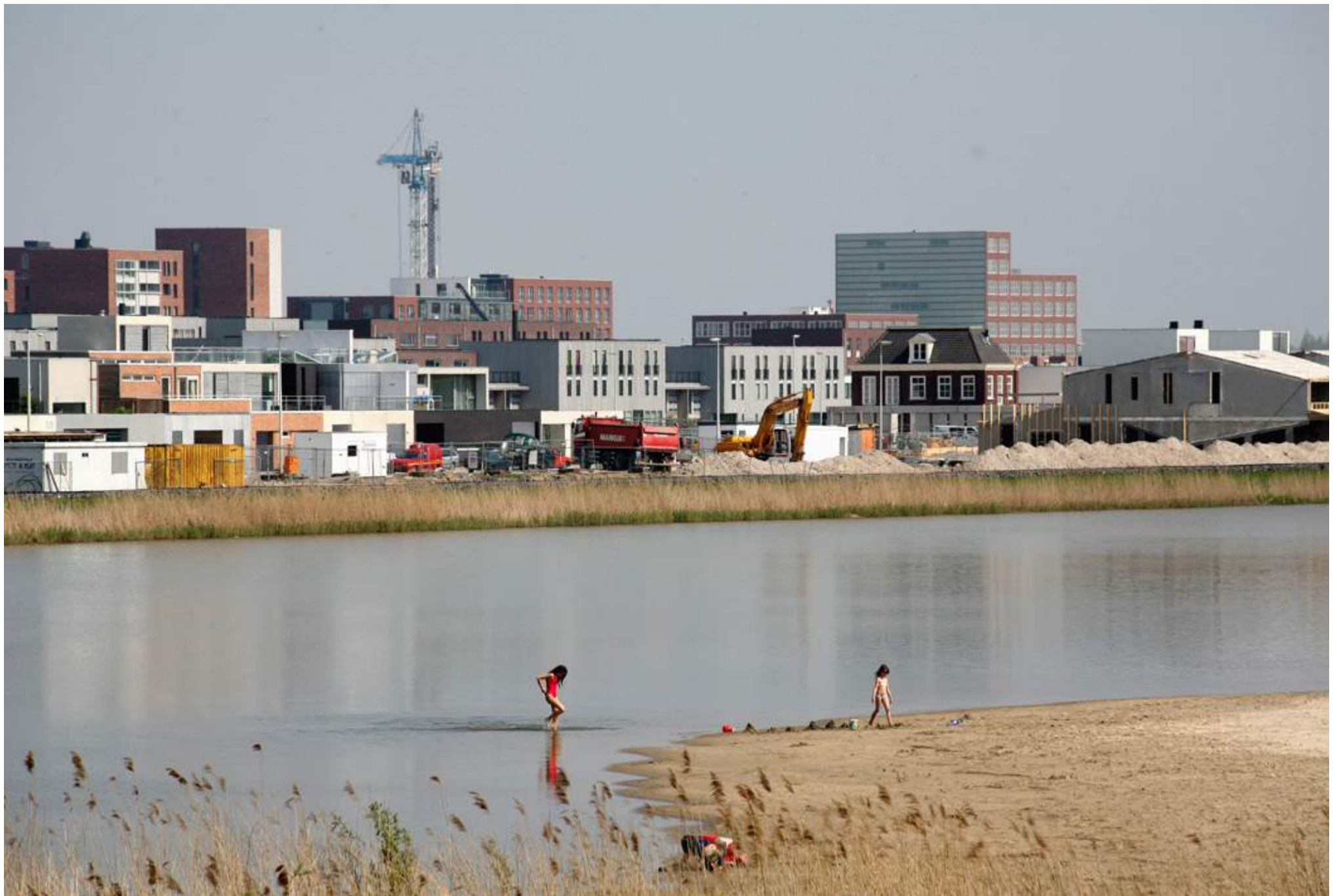
Afb. 6.1 Haveneiland in aanbouw
