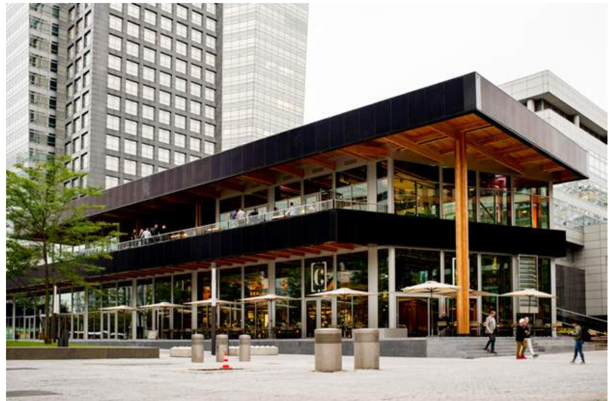
Afb. 8.6 Circulair gebouw CIRCLE van ABN AMRO op de Zuidas, Amsterdam Zuid
